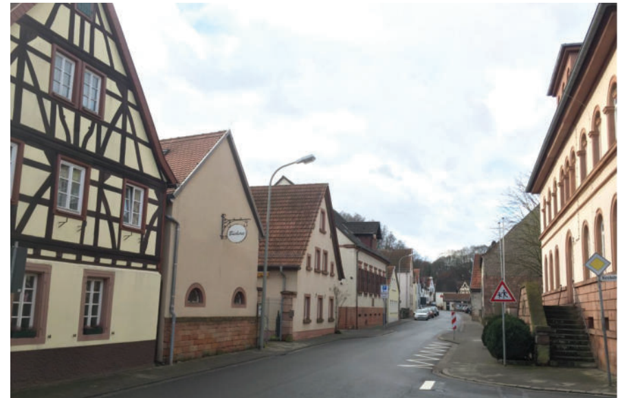
Typische Straßenrandbebauung mit harmonischer Baustrukturen; giebel- und traufständige Bauweise im Wechsel
