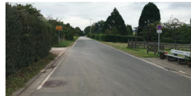
Fehlender Radweg entlang der L394
