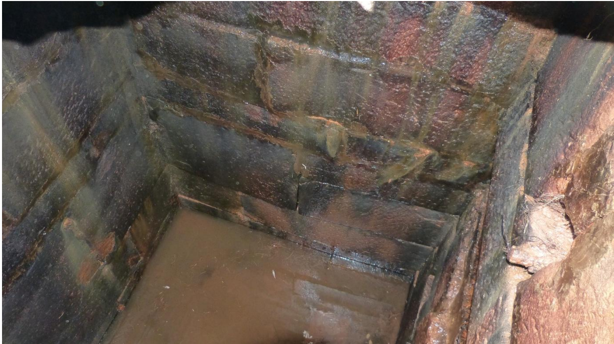
Blick in die gemauerte Brunnenkammer im fast leeren Zustand Foto: Klaus Stuppy
